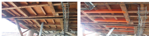
(a) 平台甲板改造前结构 (b) 平台甲板改造后结构 图8 平台甲板改造前后结构对比图
