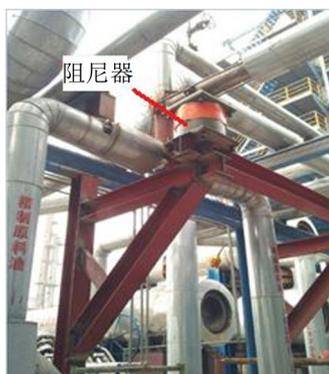
图8 阻尼器实际安装图
