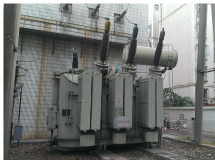
图1 110 kV 变压器实照图
